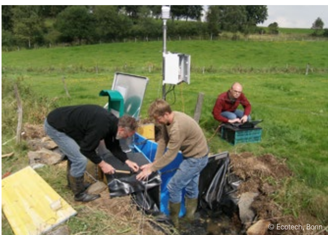
Aufbau der hydrologischen Messstation Rollesbroich im TERENO Observatorium „Eifel/Niederrheinsche Bucht“
